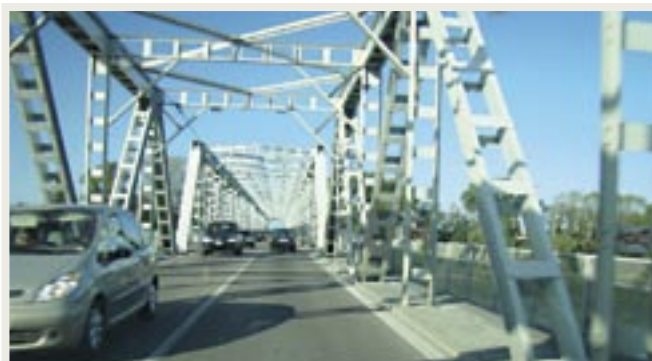
OSTACOLI FISSI Un esempio di barriera rigida non protetta, a rischio per moto e automobili.
