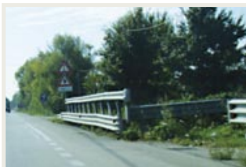
CUSPIDI APPUNTITE Le barriere interrotte possono entrare come baionette nei veicoli, pericolose le cuspidi appuntite.
