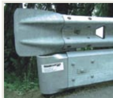
GUARD RAIL PROTETTO La protezione continua è più sicura per i motociclisti, ma la parte terminale è a rischio.
